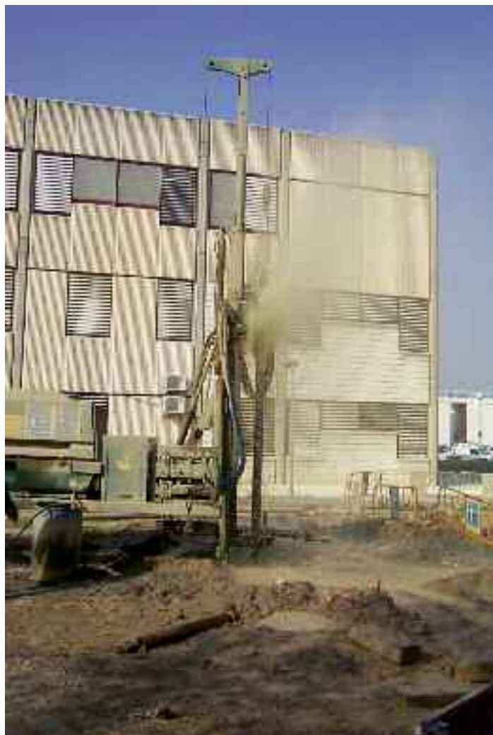
Figura 1. Fotografía de la excavación de los pozos.
