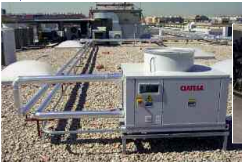
Figura 2. Esquema de principio de la instalación experimental, bomba de calor agua-agua y grupos hidráulicos, bomba de calor aire-agua sobre la cubierta del edificio.
